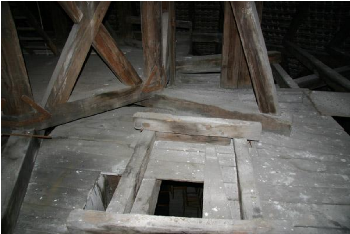
Foto 2006: Resterne klokketårnets skillerum til sejerværket. Bagerst ses døråbningen. og tv for soklen til værket ses hullet til pendulet
